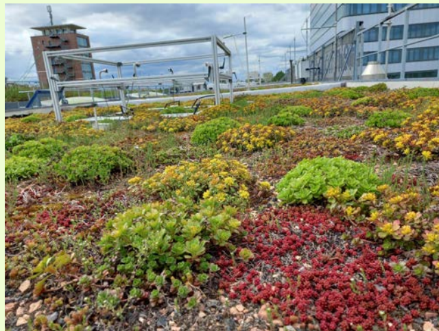
Extensive Dachbegrünung im Mai 2024 (Foto: Lucie Moeller)
